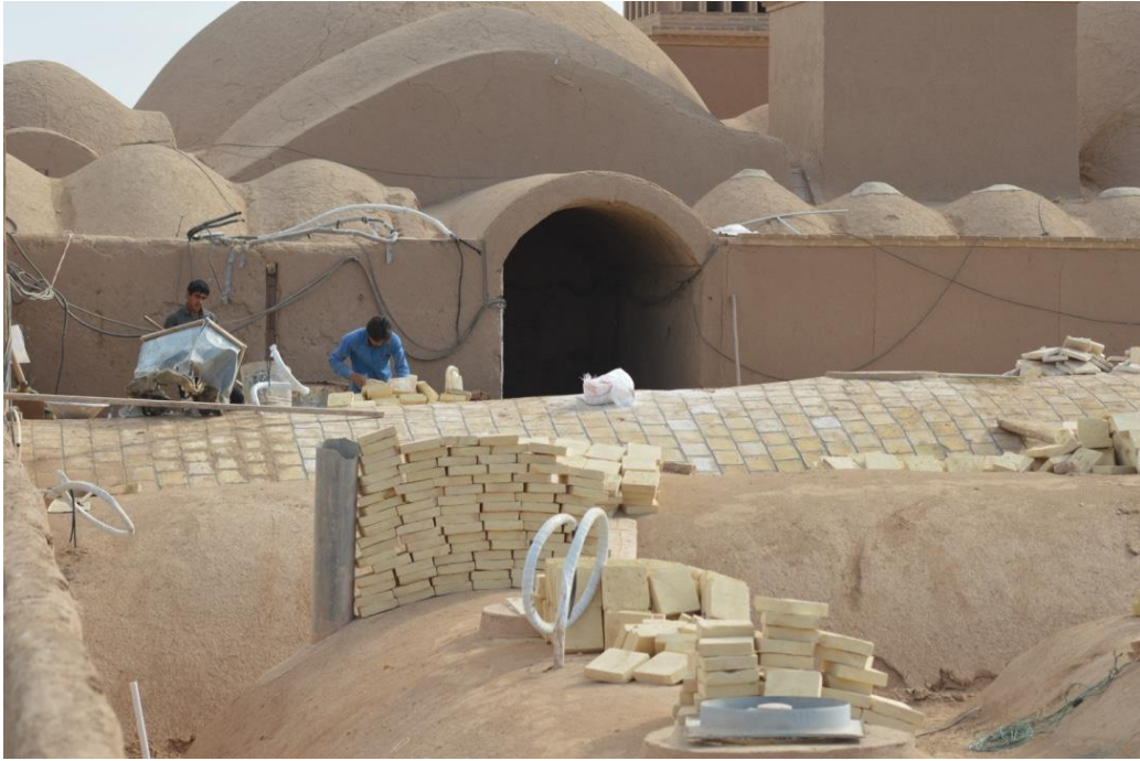
Yazd, giardino di Dolat Agabat, interventi di riabilitazione in Adobe (terra cruda)
