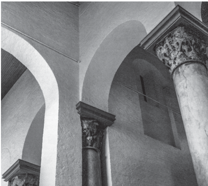
19-20/ Basilica St. Bonifaz, interno, le connessioni tra colonna e muro.
