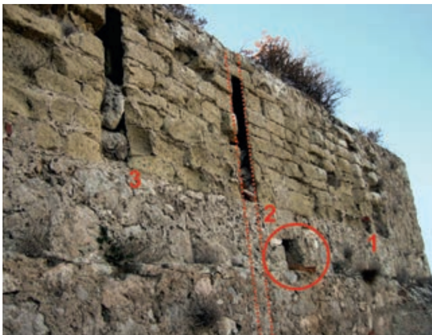
15/ Particolari delle feritoie e del foro per lo smaltimento delle acque presenti sul muro nord-est (prospetto esterno).
